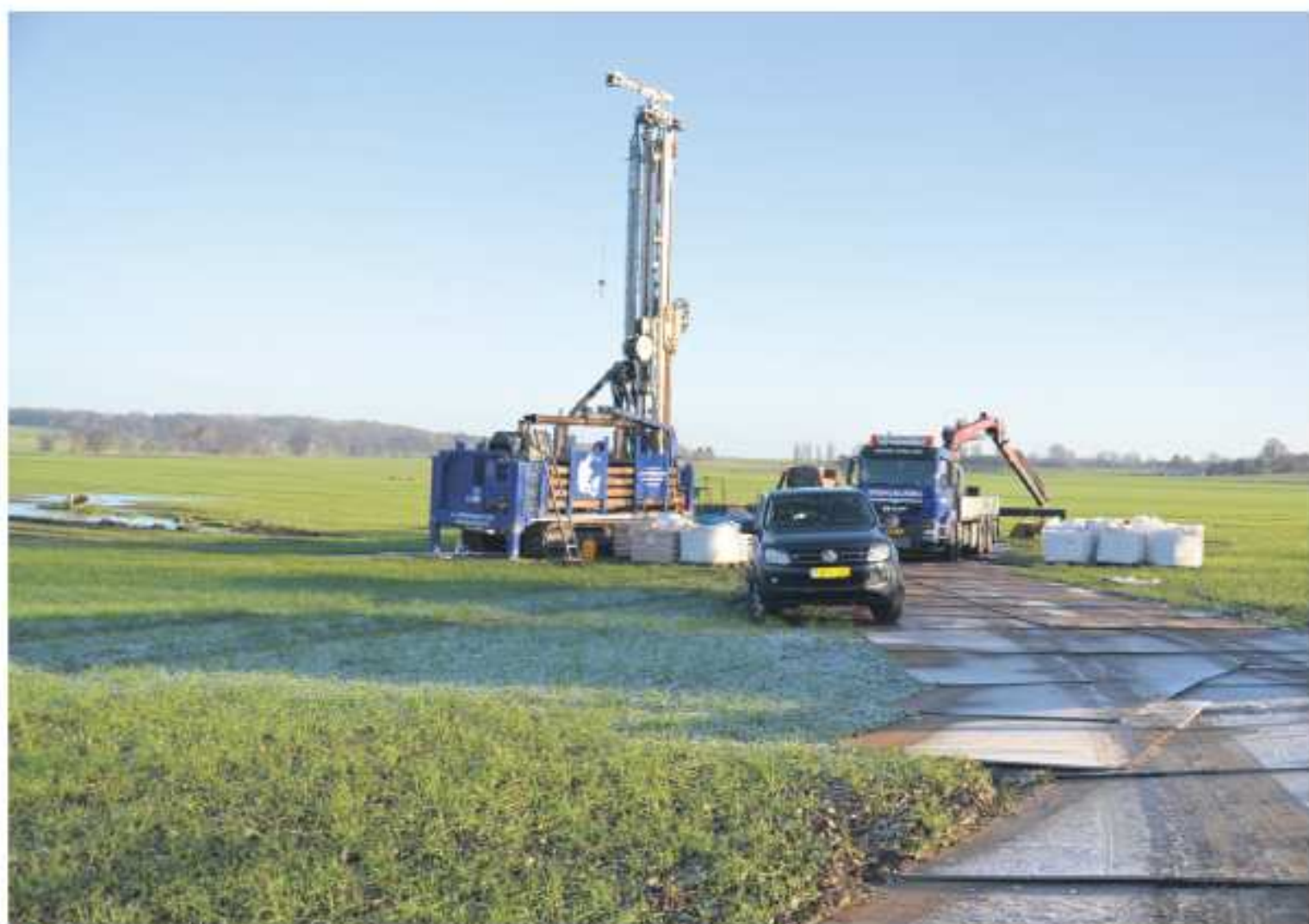
Det er en kraftig vandåre, borefolkene har ramt langt nede i jorden ved Lyngbygårds Ådal. Der er så kraftigt tryk på, at vandet står op i et fem meter højt springvand, når der åbnes for hanen. - FOTO: HENNY ERIC HSJEN
