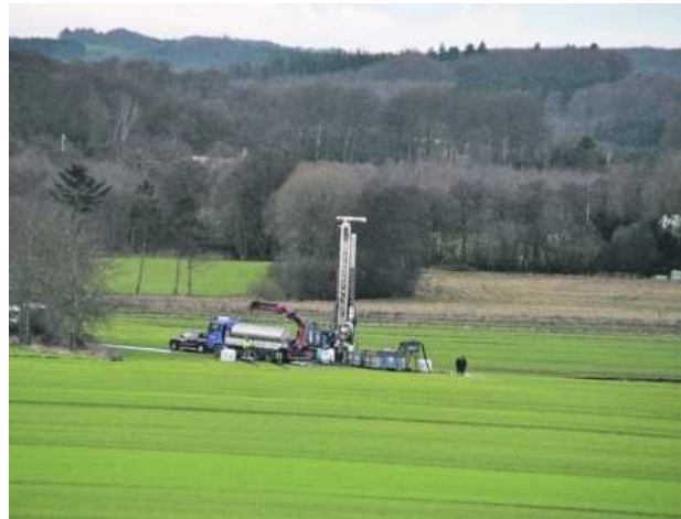
Galten Vandværk har etableret en ny boring i ådalen vest for Galten. Foto: Henny Erichsen
